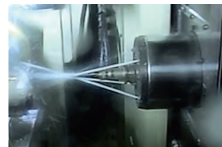
主軸クーラント配管 / Coolant piping
